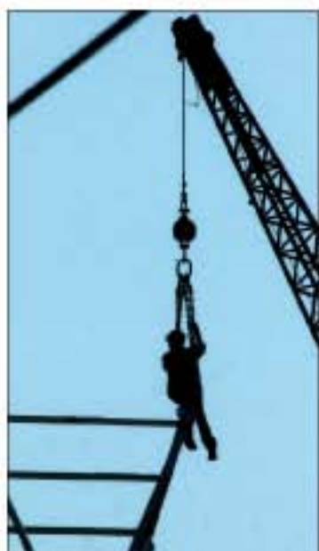
Trabajos en la estructura de metal de la nueva catedral de Acapulco ■ Foto David Noh Colli
